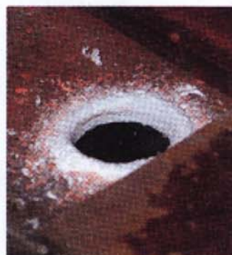
Hål i botten för givare till framåtseende lod.
